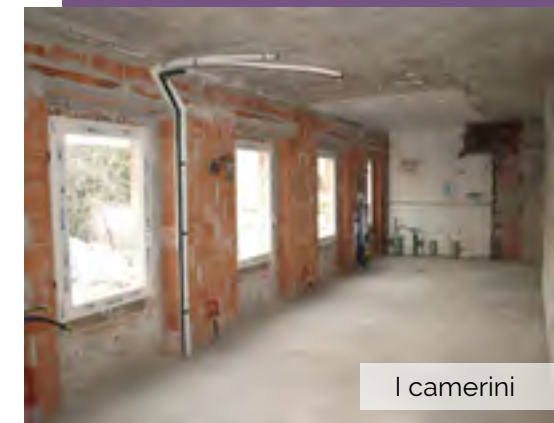
L'interno del cantiere
