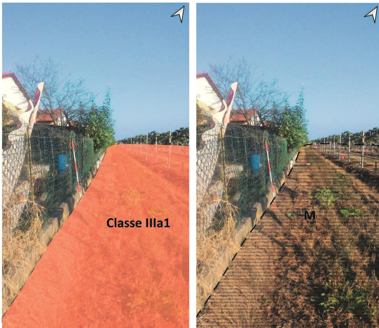
**Figura 4: Limite dello scenario di pericolosità M aggiornato al PGRA – 2015, con battenti massimi di 20-30 cm e per medio-bassa energia. A sinistra è riportato il limite per la Carta di Sintesi, a destra per la carta dei Dissesti. Il muretto in cls è più alto di 40 cm ed è sufficiente per contrastare i battenti a medio-bassa energia.**
