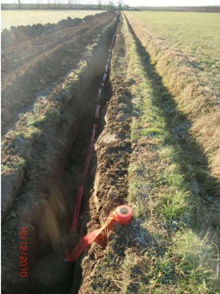
POSA CAVO DI ALIMENTAZIONE IMPIANTO FOTOVOLTAICO – 10/12/2010
