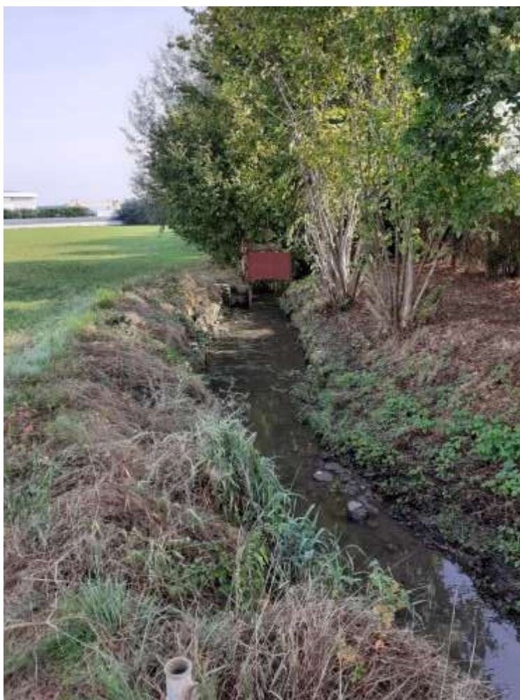
IMMISSIONE TUBAZIONI CANALE IRRIGUO NELLA BEALERA
