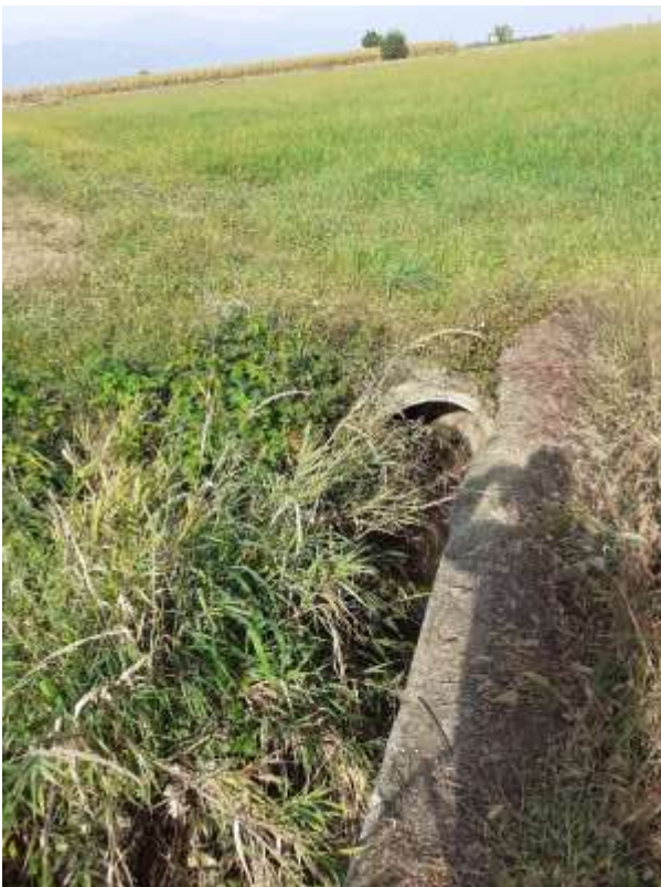
TUBAZIONE ALIMENTAZIONE CANALI IRRIGUI DA POZZO SAN QUIRICO - VISIONE D'INSIEME E DETTAGLIO
