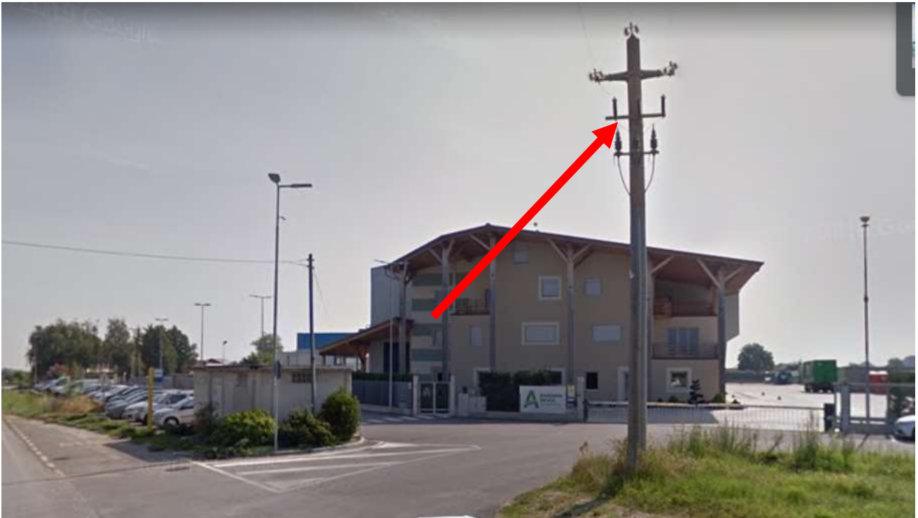
VISTA PALO DI TESTA DI CUI SI RICHIEDE LA RIMOZIONE
